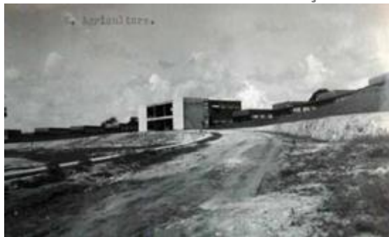
Figura 3: Prédio da Reitoria da UFRPE em construção na década de 1930
