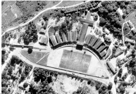
Antiga Vista Aérea da UFRPE
