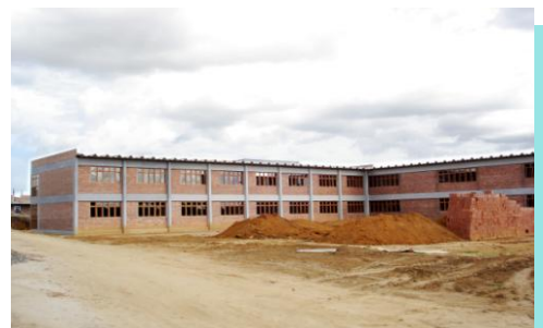
Construção - Prédio da Unidade Acadêmica de Garanhuns
